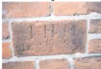
Gevelsteen in de voorgevel
