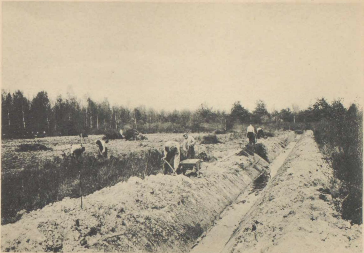
GRAVEN VAN AFWATERINGSLOOT.
