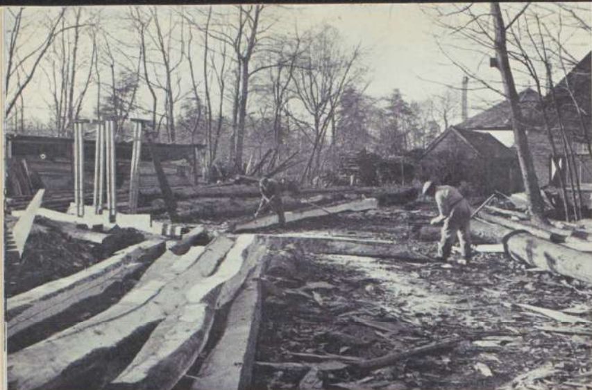
Het rondhout wordt gekapt tot balken
