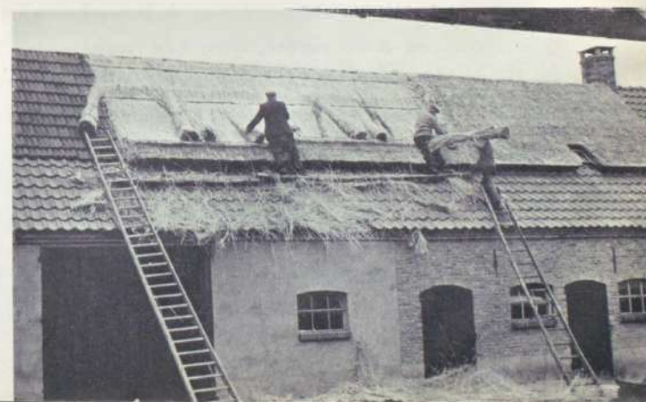
De dekkers aan het werk
